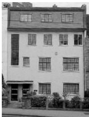
Brugmannlaan 364-366. Eigen huis van architect Obozinski.
